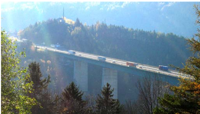
Fig. 3 Una lunga carovana di mezzi pesanti attraversa il "Ponte Europa" in Austria in un pomeriggio di autunno. Il viadotto è parte del corridoio di transito che collega la Germania meridionale con l'Italia settentrionale.
