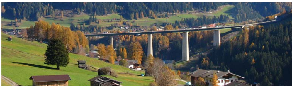
Fig.1 Una bella vallata è attraversata dal corridoio autostradale del Brennero/Brenner. Il viadotto si estende sopra parte dell'abitato di Steinach/Tirol.
